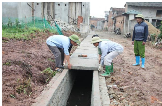
Cống thoát nước kín
